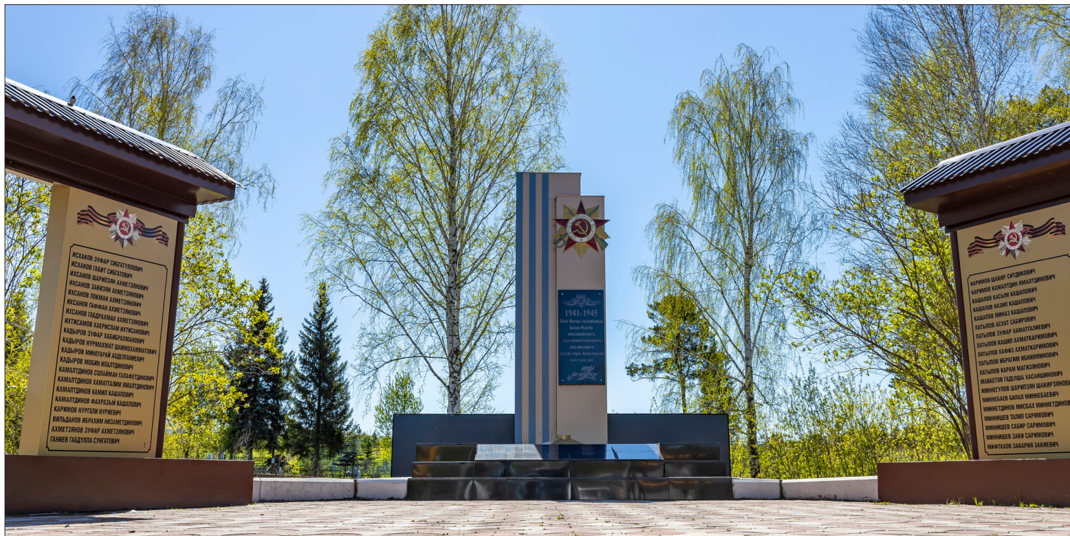
В селе Нижние Чершилы обновили фасад памятника участникам Великой Отечественной войны. Его облицовали плиткой и оштукатурили / ФОТО СЕРГЕЯ ТРУСОВА
